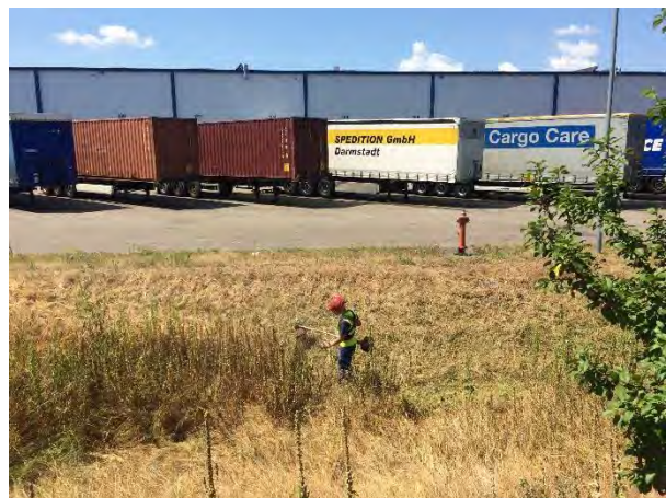
Logistikbereich im Osten; das Regenrückhaltebecken wird soeben gemäht 16.07.2018
