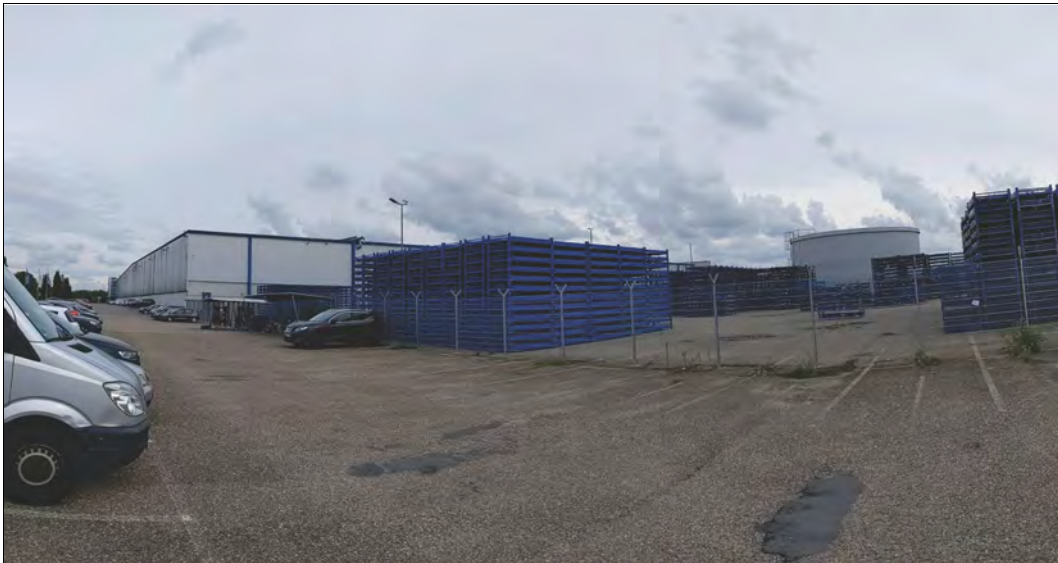
Abb. 2: Messpunkt 1: Mitarbeiterparkplatz vor Außenlager (Blickrichtung Süden)
