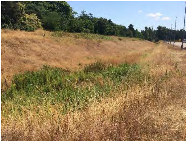
Wall mit vorgelagertem Regenrückhaltebecken im Osten 16.07.2018
