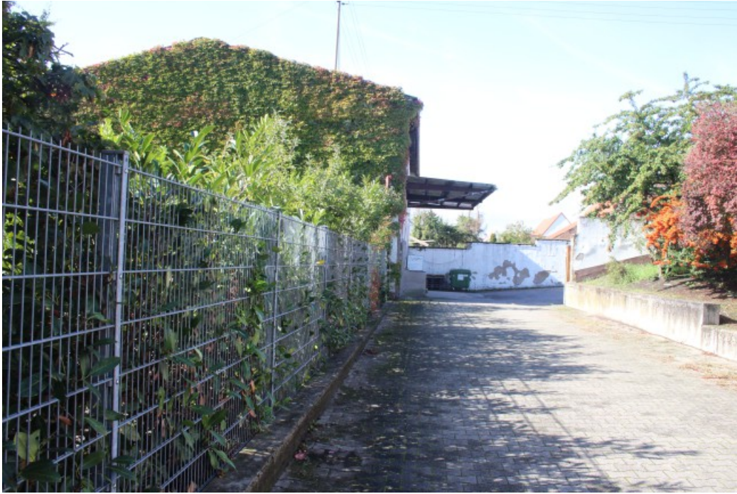
Abbildung 2: Einfahrt südlich Feuerwehrgebäude und Ostfassade Werkstatt
